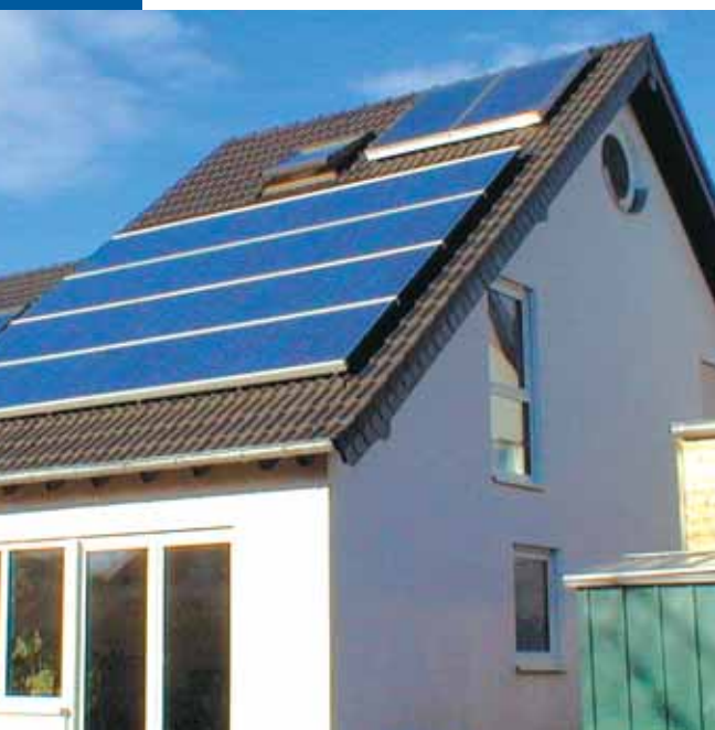
Solarwärme und Solarstrom auf einem Dach genutzt.
