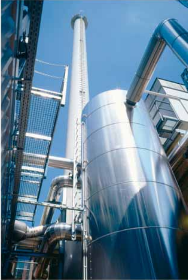
Für den neuen 33 m hohen Kamin war aufgrund der geologischen Bedingungen ein Spezialfundament nötig.
